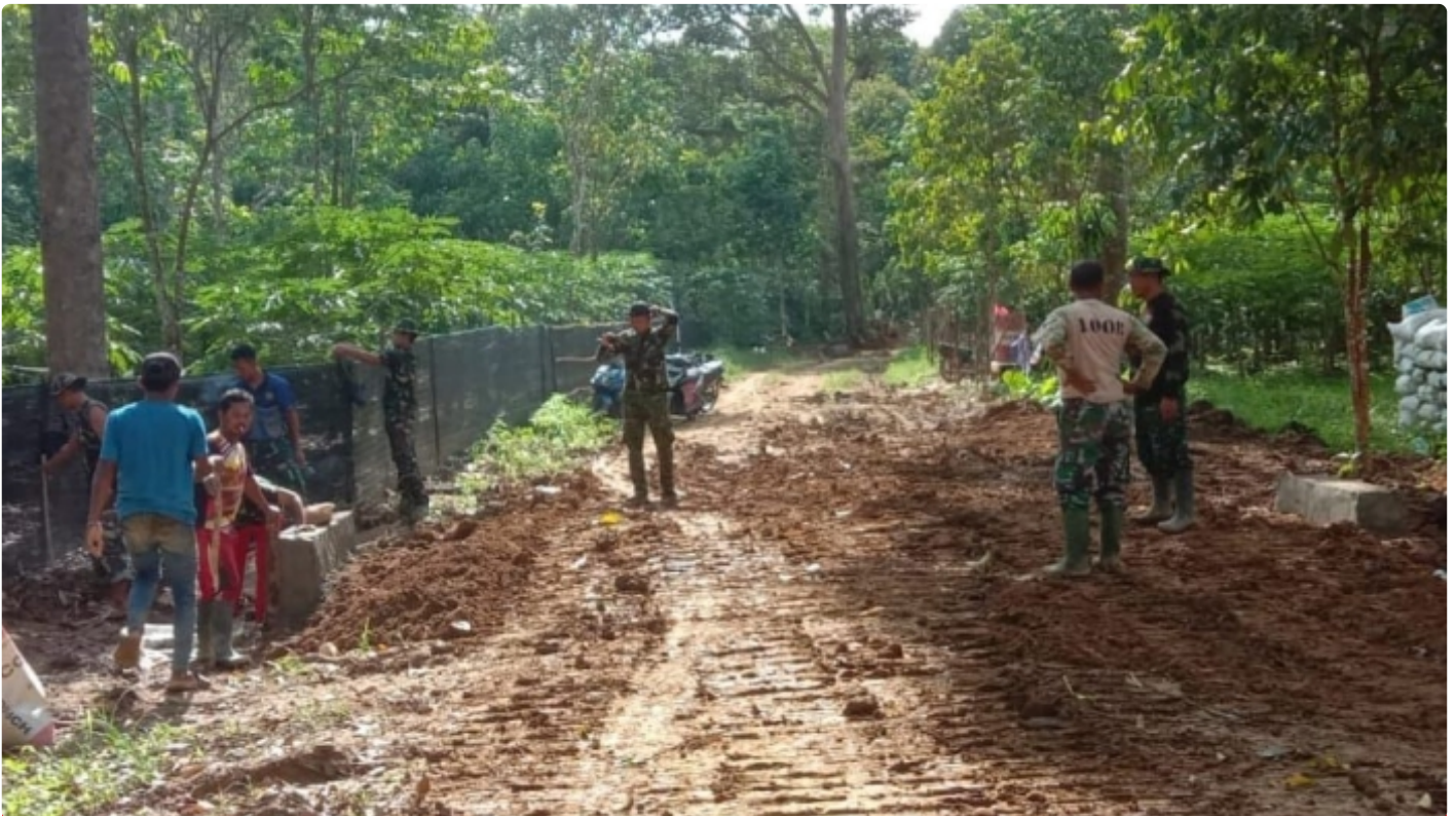
5 Titik Gorong-Gorong Akan dipasang di Lokasi TMMD Ke-115 Kodim 1008/Tabalong
