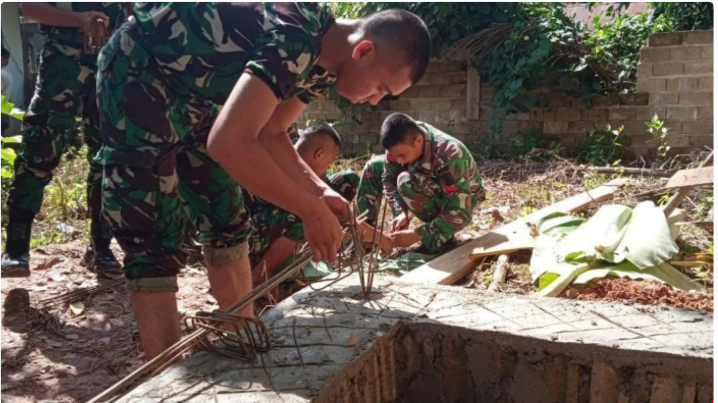
Pengerjaan Rehab Kamar Mandi dan WC Mushola Nurul Iman Capai 40%
